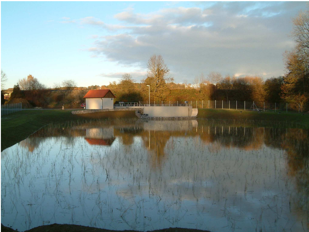
RÜB Klutern am Bahnhof mit Retentionsbodenfilter
