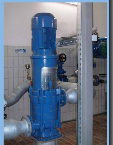
Bild: Technische Werke Schussental (TWS)
