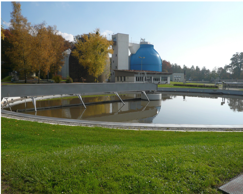
Vorklärbecken im Klärwerk
