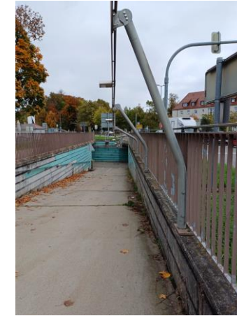
Lichte Höhe für Radverkehr bei Beleuchtungsanlage nicht ausreichend
