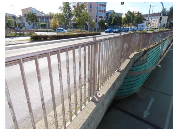
Erneuerung Korrosionsschutz des Geländers
