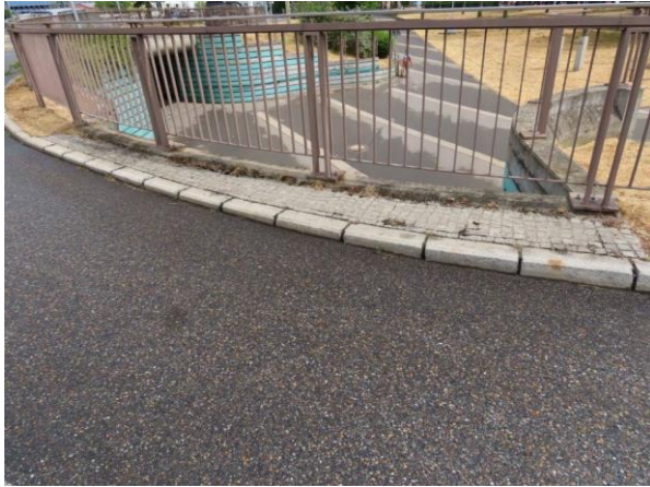
Randbereich Unterführung Umbau der Kappen
